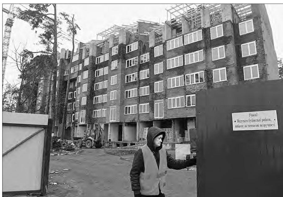
Відновлювальні роботи в багатоповерхівці.
